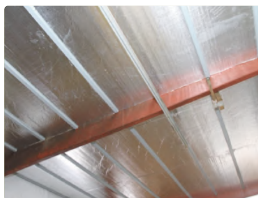
Stálgrindafjós, klætt með 50 mm plötum með áli og málaðir listar undir.
