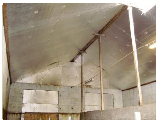
Staðsteyptri hlöðu breytt í fjós, klætt neðan á bönd með 50 mm plötum m/áli.
