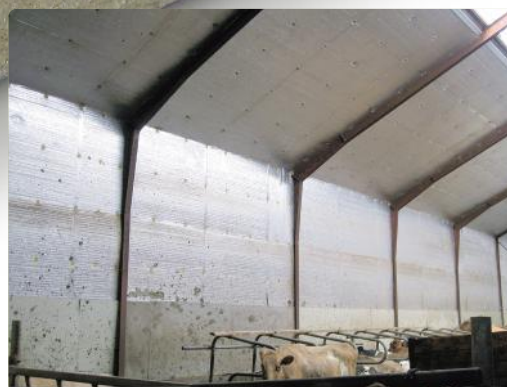
Stálgrindaskemmu breytt í fjós, klætt með 50 mm plötum í þak og 30 mm plötum á vegg.
