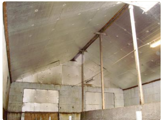
Staðsteyptri hlöðu breytt í fjós, klætt neðan á bönd með 50 mm plötum m/áli.
