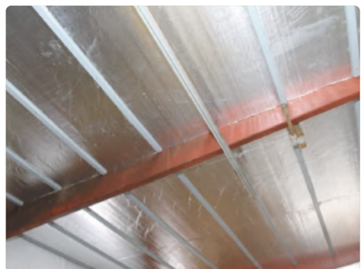
Stálgrindafjós, klætt með 50 mm plötum með áli og málaðir listar undir.
