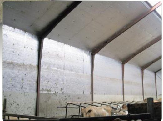
Stálgrindaskemmu breytt í fjós, klætt með 50 mm plötum í þak og 30 mm plötum á vegg.
