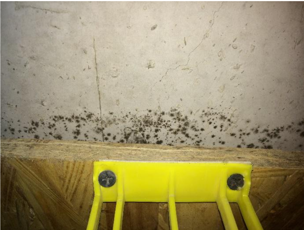
Mynd 3. OSB-krossviður er festur á kaldan steinvegginn og hann myglar og steypan einnig
