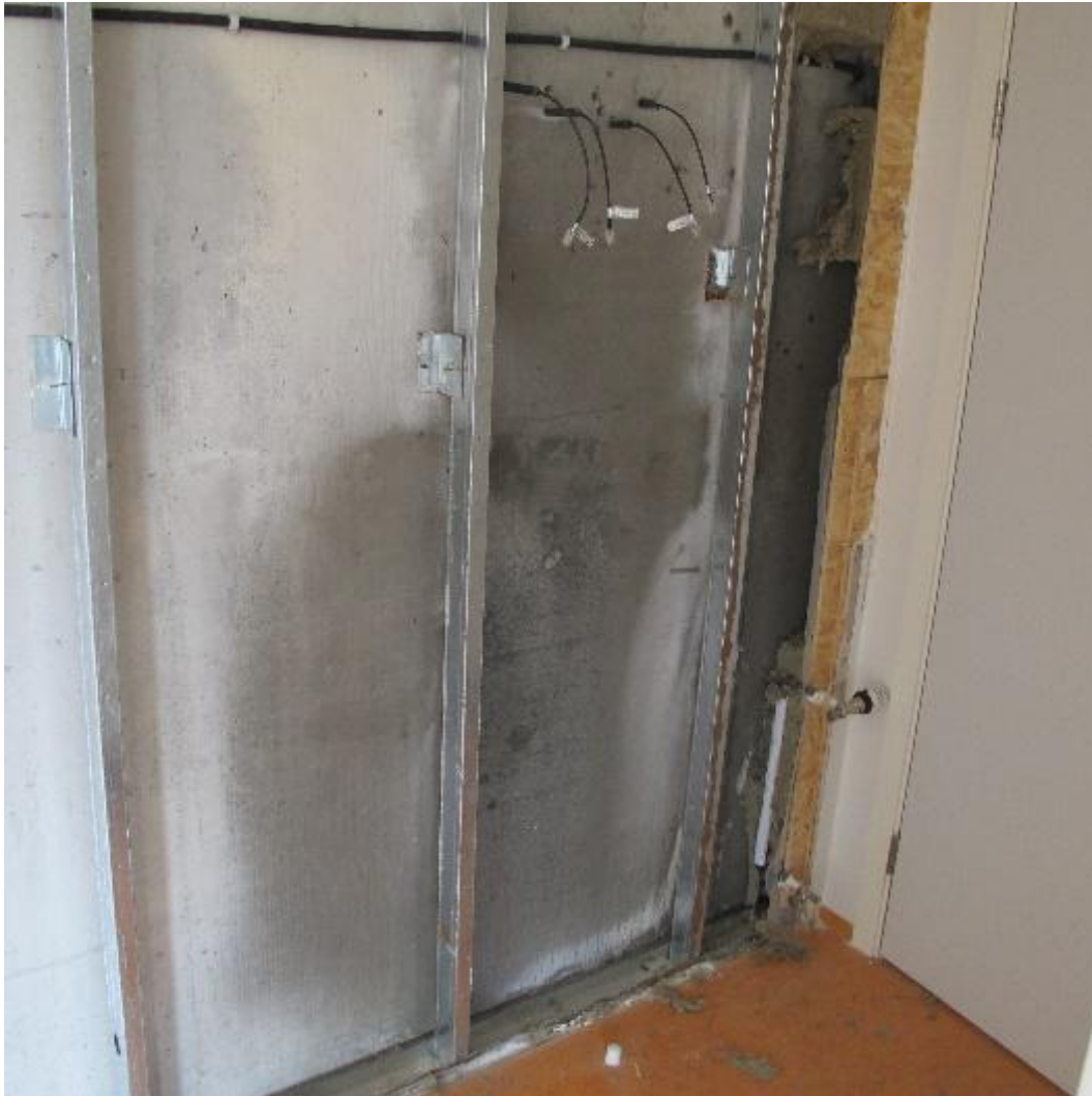
Mynd 7. Rennblautur útveggur rétt eftir að hann var opnaður.
