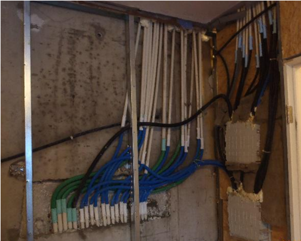
Mynd 1. Raflagnir lagðar út að og í kaldan útvegg.
